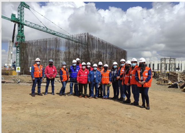
Personal de la AETN visita obras de construcción del Centro de Investigación Nuclear
