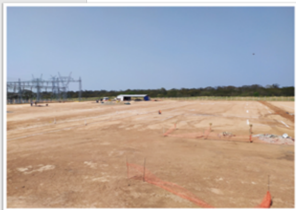
Sitio de construcción SE Brechas
